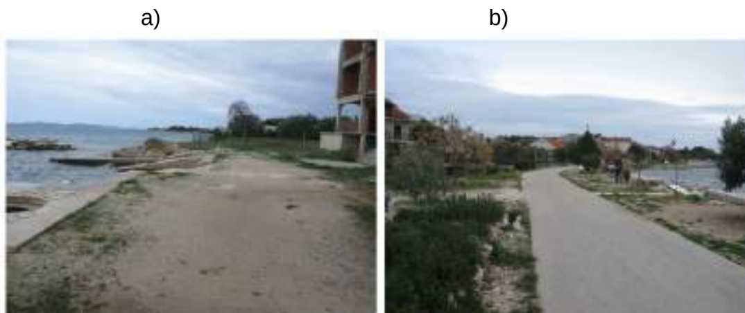
slika 4. Opsežna nasipavanja duž morske obale (a) Obalni nasip na jugoistočnoj periferiji Sv. Petra (b) Obalni nasip na području sjeverozapadne obale u Turnju
