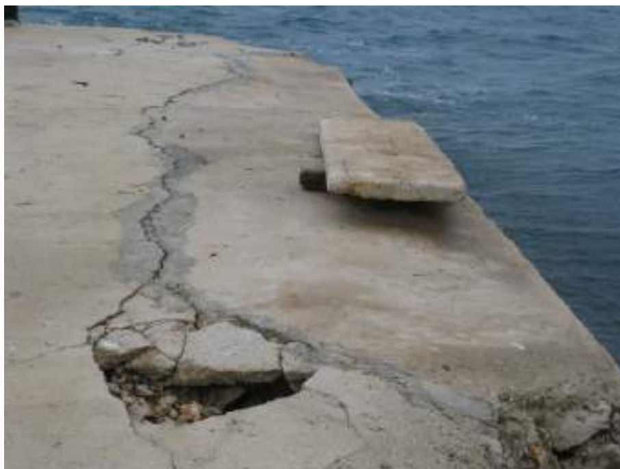
slika 11. Postojeći mul uz buduću CS Sv. Petar 3 evidentni je dokaz erozijskog djelovanja mora na tom području
